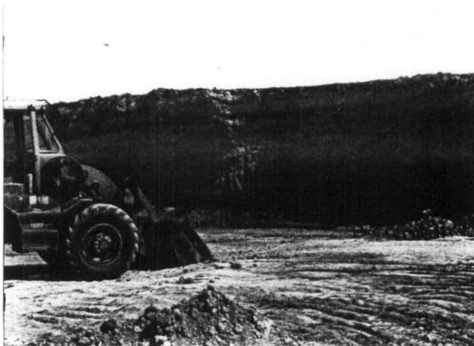
Estación 502 (37), (Crespos). Explotación de arcillas miocenas de la Depresión del Duero.
