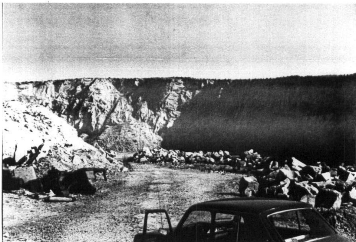
Frente abandonado de una cantera de granito para áridos en Cardeñosa. 40-37.
