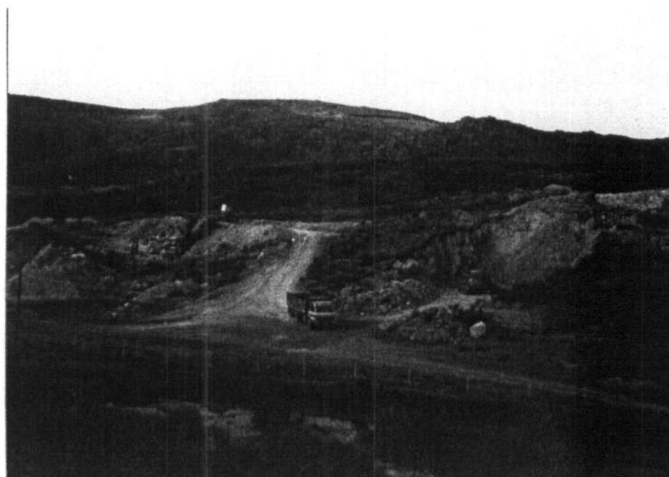
Explotación, en Venta del Obispo, de pórfido para la construcción de una carretera próxima. Estación 427-44.
